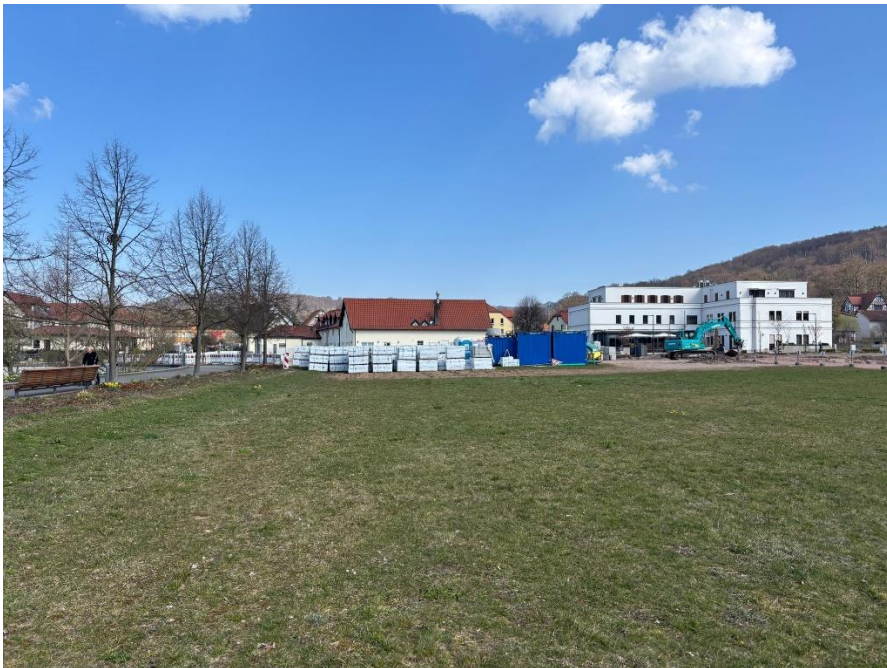
Blick in Richtung neuer Stadtplatz (im Bau)/Kurpromenade
