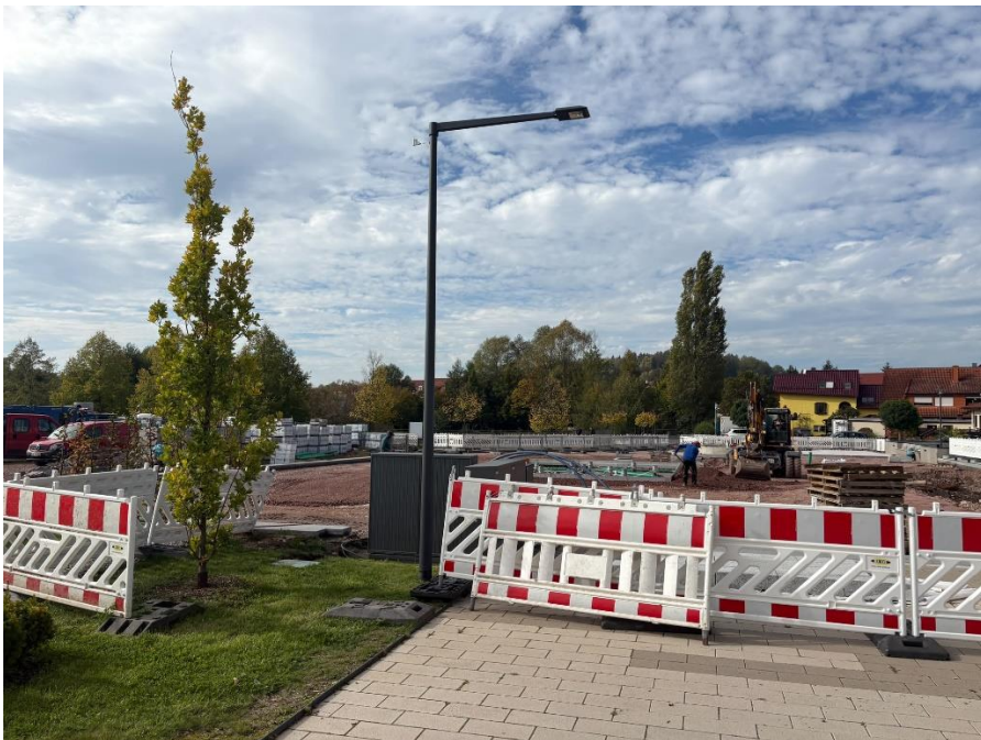
Kurpromenade/Ecke Stadtplatz (im Bau)
