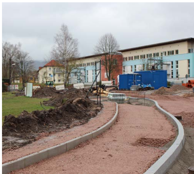
2019: Baustelle Breiter Fahrweg
