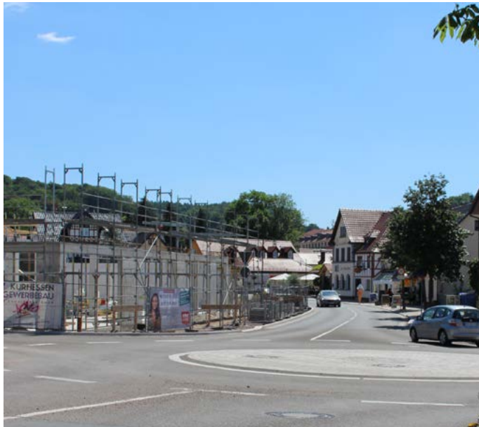
Der Kreisverkehr und die Baustelle Herzog-Georg-Carree 2019
