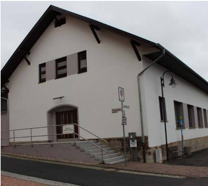
Sanierte Fassade: Alte Turnhalle Schweina
