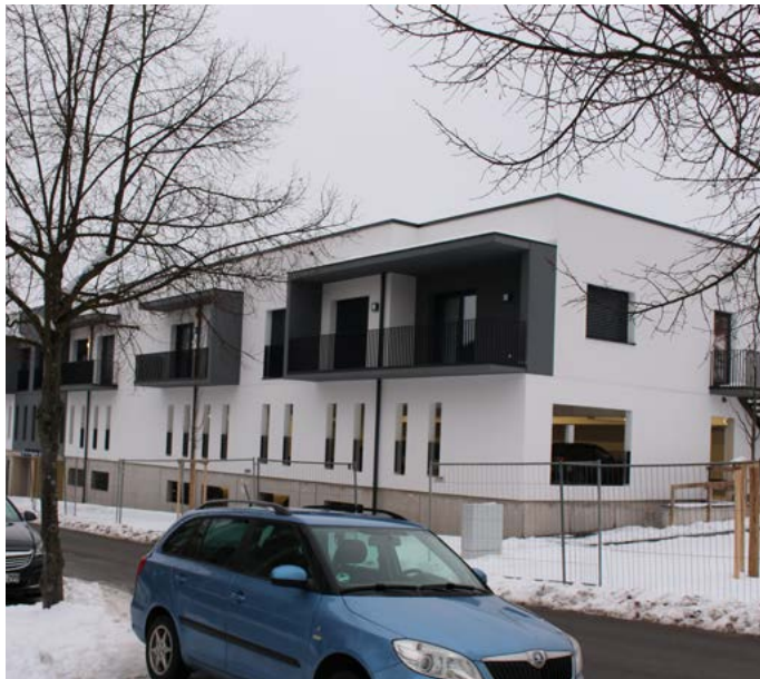
Parkhaus und Ferien-Apartments in der Kurpromenade
